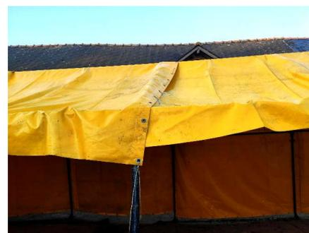
Hormis les extrémités, chaque bâche de toit doit être fixée à la ferme d'un côté et recouvrir sa voisine de l'autre.
