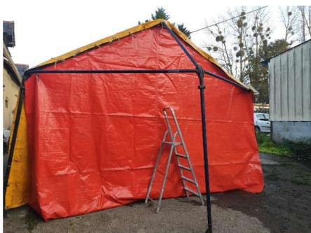
On a pas les bâches adaptées au pignon, donc oui, c'est un peu moche et on perd de l'espace, désolé. Mais c'est **nécessaire d'installer quand même les pignons** pour la stabilité de la structure.
